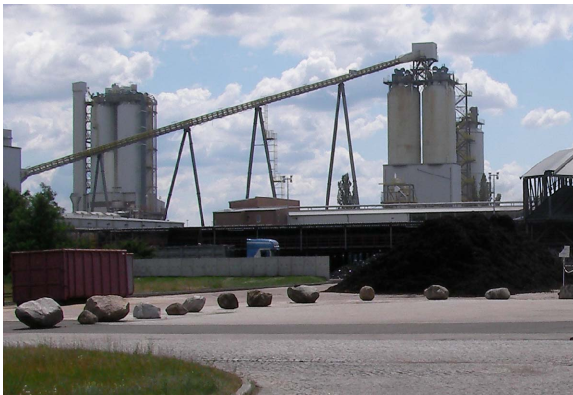
Рис 5: Батареи силосов для угольной пыли по 1000 м 3 в силосе на востоке Германии Под силоса на загрузку подаётся автомобильный или жд. транспорт.
